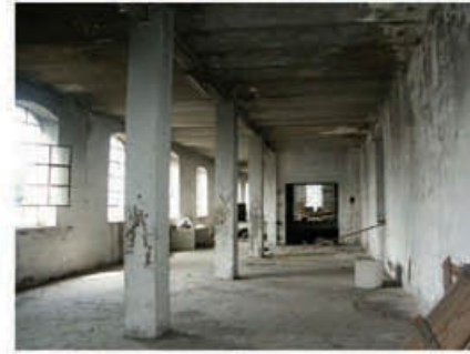
LIVELLO -1 VISTA MAGAZZINO
